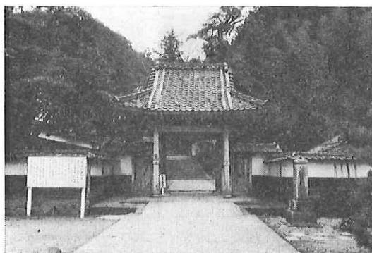
写真3 久美浜町本願寺正門
