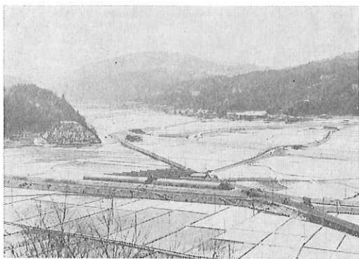
写93 樋爪庄といわれていた奈佐谷（中央は大岡山）
