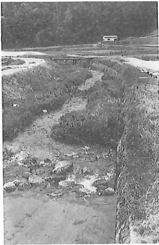
写真 70 旧小野橋下流
