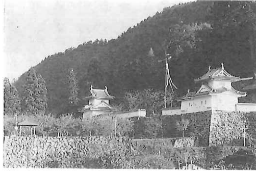
写真 312 完成した出石城隅櫓
