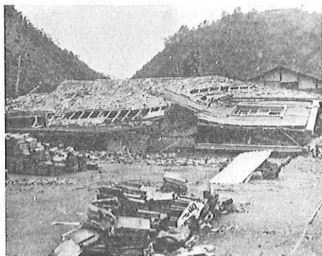
写235 震災で倒壊した港西小学校校舎
