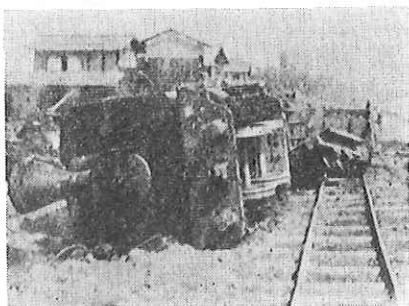
写156 北但大震災で横転した円山川改修の土砂運搬用機関車
