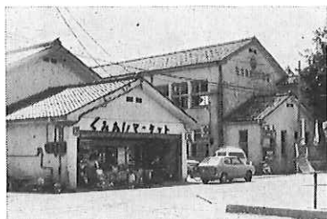
写真211 三方農業協同組合庁舎
