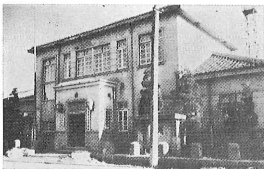
写真207 日高警察署庁舎（昭和14年新築）
