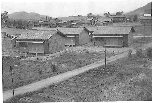
写真 297 町営住宅建設される (1963年〔昭和38〕・小人地区)
