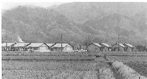
写真 298 鳥居地区に完成した3DKの町営住宅
