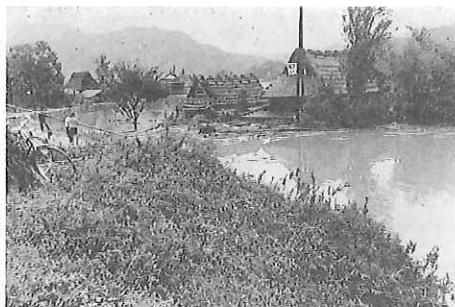
写真 283 伊勢湾台風による被害（嶋区）
