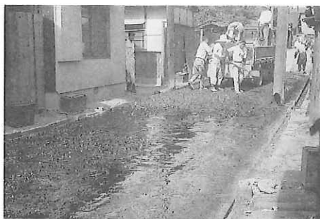
写真 290 道路改良(防塵舗装)
