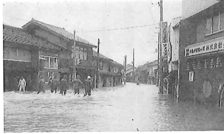
写真 286 台風20号による被害（川原区）
