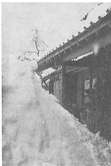
写真 288 軒下に積み重なった大量の雪(38豪雪)
