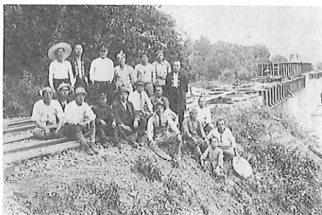
写真 188 台風被害による鉄橋の復旧作業
