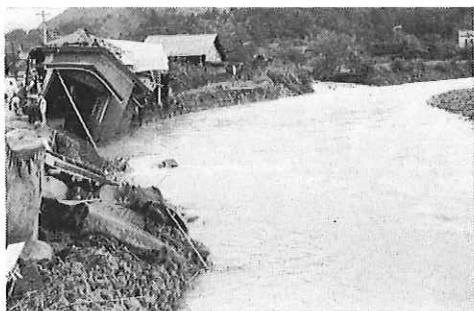
写真227 台風被害状況
