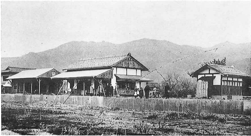
11 出石鉄道出石駅（開通前の光景）
