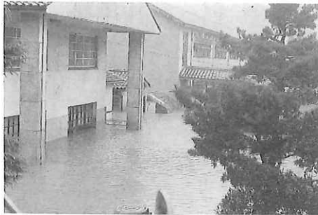
写真 316 台風20号により中学校浸水
