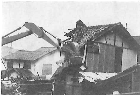
写真 337 小集落改良事業（工事風景）
