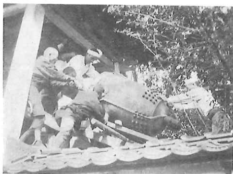
写真 228 強制供出で吊り鐘を出す (西宗寺)
