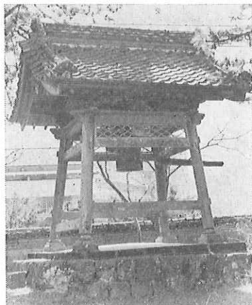
写65 妙国寺の鐘楼（高知市 潮屋崎町）
