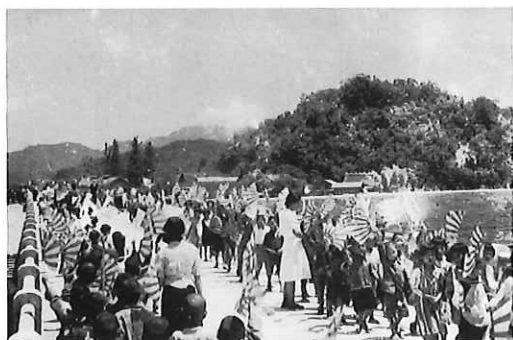
22 伊豆橋竣工渡り初め (1942年〔昭和17〕6月28日)
