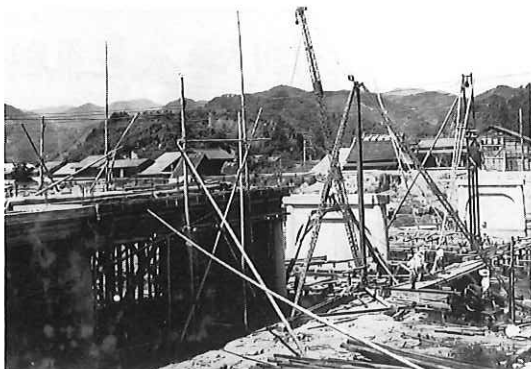
20 堀川橋架け替え工事 (1937年〔昭和12〕11月6日 渡り初め式を挙げる)
