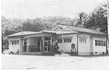
写真277 八代生活改善センター
