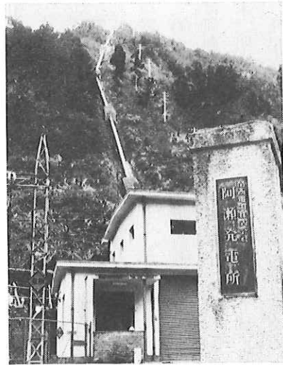
写真141 現在の阿瀬発電所
