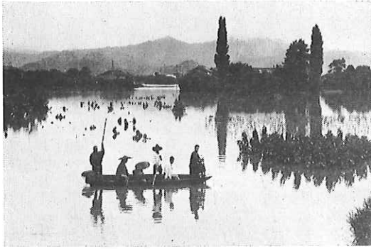
写真150 国府地区洪水風景（国府村誌より）
