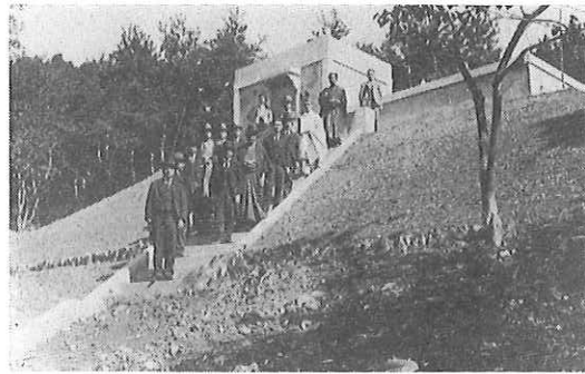
写真145 完成した上水道辺坂中継所 (赤松衛提供)
