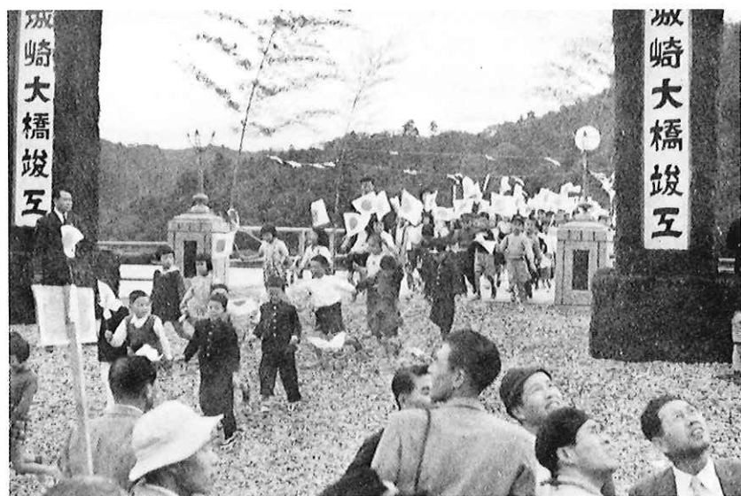
城崎大橋渡り初め（昭和31年）
