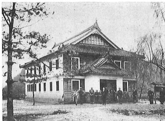
写真69 日高村東柳小学校新築校舎 (河本重成提供)
