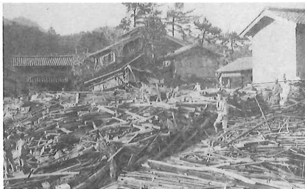
写240 室戸台風の被害（轟）
