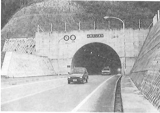
写278 江野トンネル
